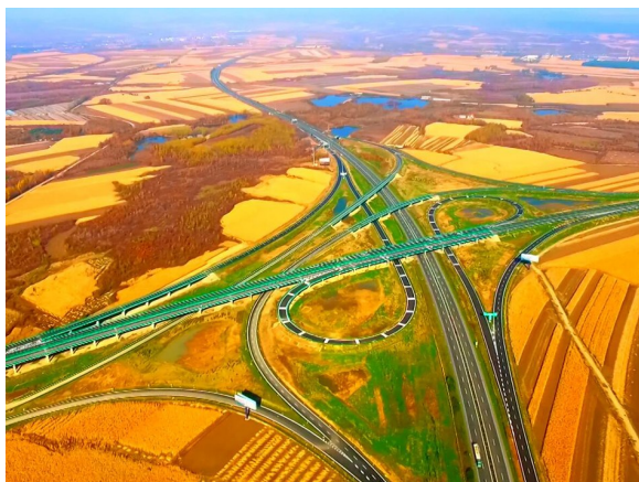
吉林省公路工程监理有限责任公司承建的鹤大高速
